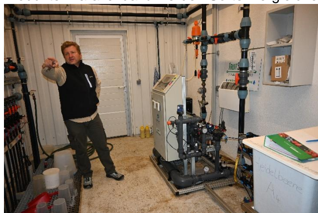
Schulleiter Halaka erläutert die automatische Wasser- und Nährstoffversorgung
